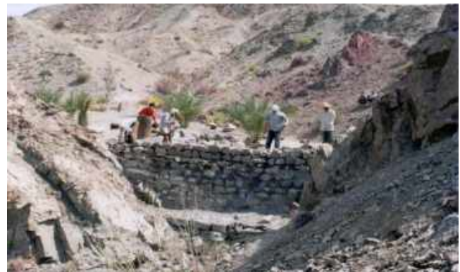
نمونه‌ای از احداث بند سنگی برای جمع آوری آب باران برای آبیاری نخلستان در هرمزگان
