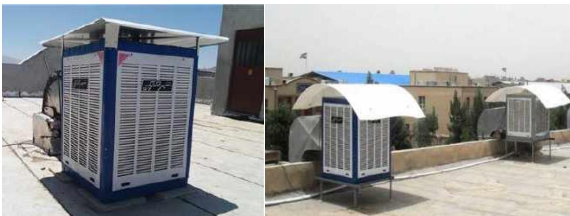
شکل ۳۰: نصب سایبان بر روی کولرهای آبی
